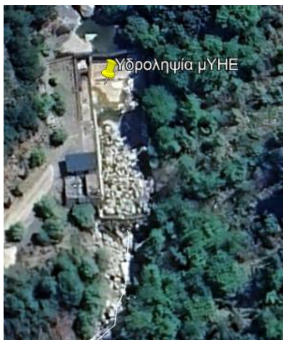
Εικ. 6-3 Θέση υδροληψίας, φράγματος και είσοδος αγωγού μΥΗΕ
