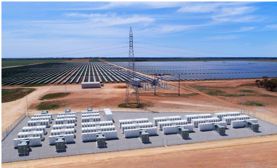
Εικ. 3-5 Gannawarra, σύστημα αποθήκευσης ενέργειας φωτοβολταϊκού πάρκου (μεγαλύτερο σύστημα αποθήκευσης στην Αυστραλία) 16 .
